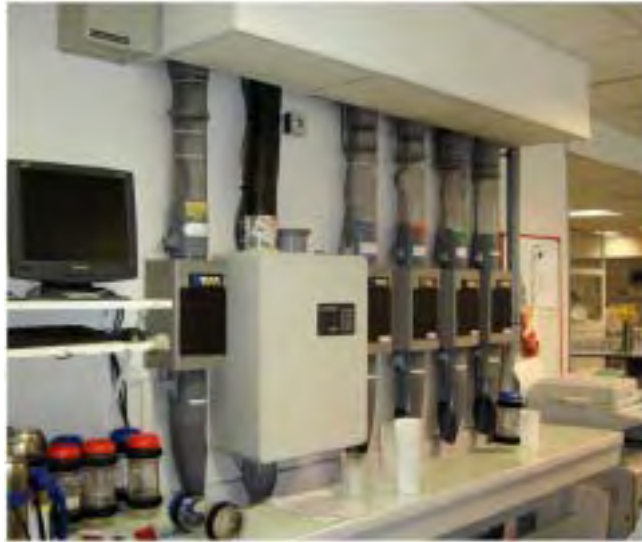
La station des pneumatiques dans la zone de tri de l'AGEB
